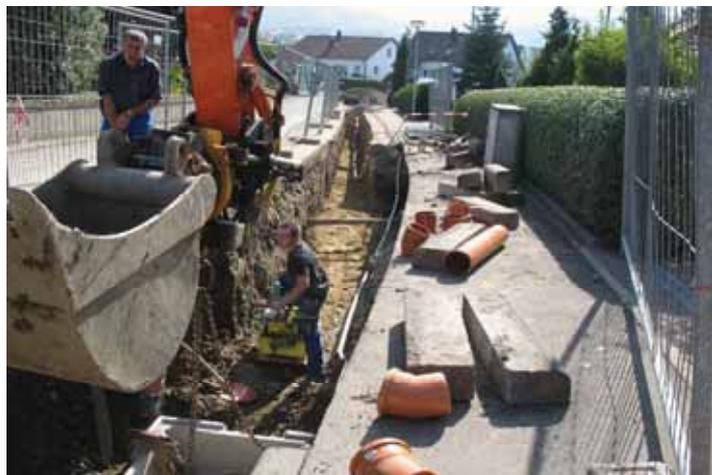
Es wurden Muffendruckrohre DN 100 verwendet. Sämtliche Hausanschlussleitungen wurden im Bereich der öffentlichen Straße erneuert.
