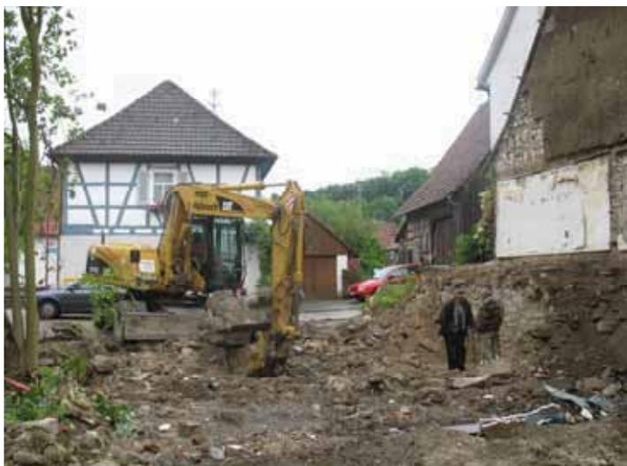
Da das Gebäude Schulweg 2 direkt an das Gebäude Schulweg 4 angebaut war, musste nun dieser Giebel abgesichert, wärmeisoliert und verputzt werden. Das freigelegte Kellergewölbe sowie die Fundamente wurden mit einer Natursteinmauer aus Dietfurter Kalkstein verkleidet.
