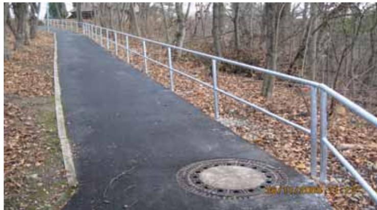
Die starken Setzungen wurden mit einem Asphaltmaterial ausgeglichen. Anschließend wurde die gesamte Fläche von 150 qm mit einer Asphaltfeinbetondecke 0/5 versehen.
