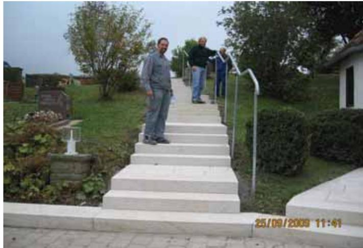
Das bestehende Stahlgeländer, das seither in die Treppenstufen eingelassen war, wurde umgeändert und seitlich einbetoniert.
