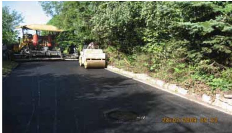
Danach wurde die ganze Fläche mit einem modifizierten Splittmastixasphaltbelag mit einer Fläche von 245 qm versehen.
