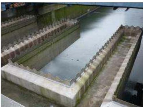
Der Zahn der Zeit nagt auch an den Betonoberflächen der Kläranlage. 2016 mussten die Oberflächen des Treppenaufgangs zum Faulturm und dessen Plateau sowie Laufbahnen und Abläufe des Regenklärbeckens saniert werden. Kosten: 7.600 €.
