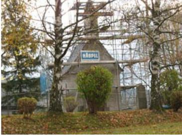
Im Zuge der Sanierung der Friedhofskapelle Thanheim wurde im Bereich der Giebelwand und den beiden Seitenwänden drei Bohreranker eingebracht, die Spannstäbe wurden vorgespannt und die Spannkanäle mit Injektionsmörtel verpresst.
