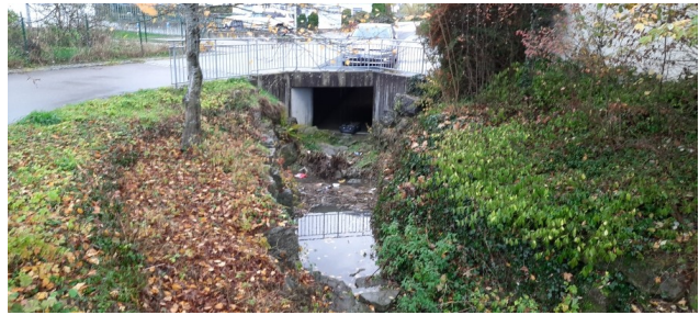
Abb. 11: Innerhalb des Geltungsbereiches befindet sich der offen fließende Bereich dieses Gewässers zwischen der Straße „Im Eibach“ und einem Gebäude auf Flurstück Nr. 1454/4.
