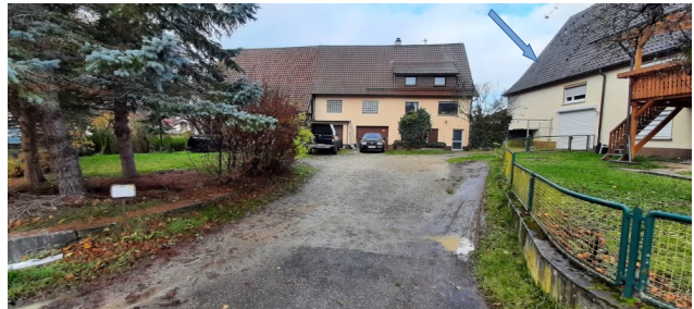
Abb. 18: Ehemals landwirtschaftlich genutztes Gebäude auf Flurstück Nr. 13. Bei diesem Gebäude hat der frühere Scheunentrakt mittleres Quartierpotenzial.
