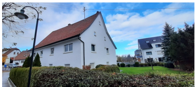
Abb. 5: Gebäude auf Flurstück Nr. 1459 (im Hintergrund Flurstück Nr. 1459) nördlich der Straße „Laibliche“.
