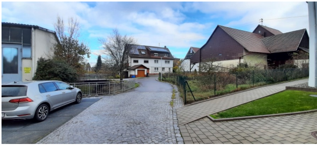
Abb. 6: Die Straße „Im Eibach“ verläuft durch den westlichen Teil des Planggebietes. Am linken Bildrand befindet sich Flurstück Nr. 1454/4, während in der rechten Bildhälfte Flurstück Nr. 1456 liegt.
