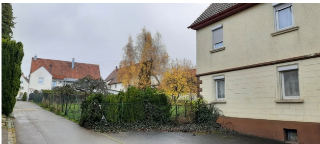
Abb. 8: Die Straße „Im Eibach“ grenzt den Geltungsbereich in nördlicher Richtung ab. In der rechten Bildhälfte befindet sich ein Gebäude auf Flurstück Nr. 1456.
