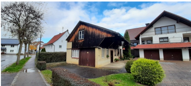
Abb. 19: Ehemaliger Lagerschuppen auf Flurstück Nr.1460. Aufgrund von potenziell für Fledermäuse nutzbaren Spaltenstrukturen im Dachbereich besteht auch für dieses Gebäude mittleres Quartierpotenzial für Fledermäuse.
