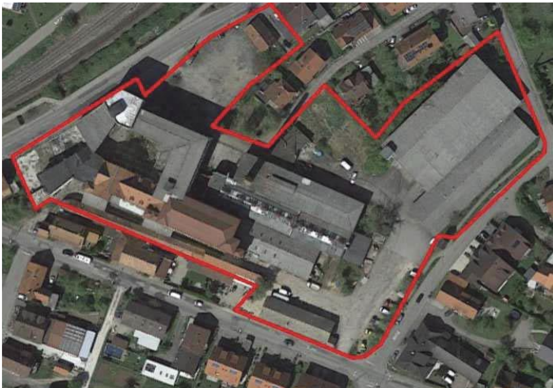
Abb. 1: Luftaufnahme vor dem Abbruch (Google Maps)
