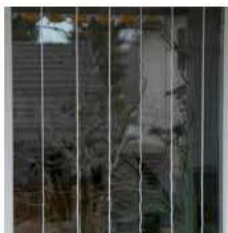
Bei Holzfenstern praktisch und günstig: Beidseitig an Rahmen je 1 Nagel einschlagen, Gummiband spannen und alle 10 cm eine dicke weisse Nytonschnur anknüpfen.
