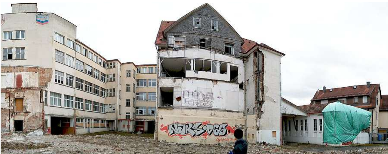
Abb. 3: Fassadenbereich entlang der Bahnhofstraße aus westlicher Richtung. Blick auf Gebäude 1 (links), Gebäude 4 (mittig) und Gebäude 6 (rechts).
