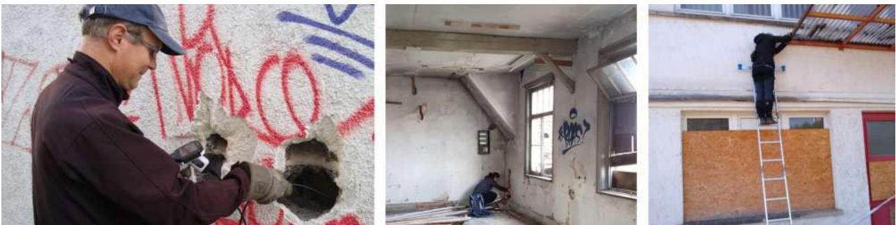
Abb. 9: Endoskopierung eines Hohlblocksteins; Ausleuchten von Spalten; Kontrolle der Anschlussfuge des Vordachs
