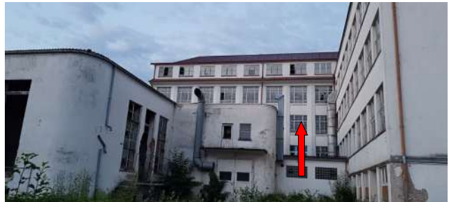
Abb. 20: Einflug in das Gebäude 4-Ost am 12.08.21
