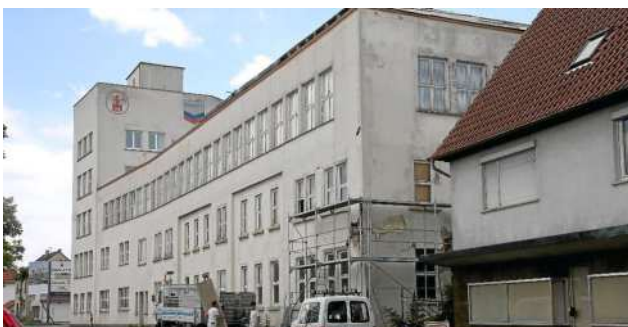
Abb. 22: Gebäudebestand vor den Abbrucharbeiten im Jahr 2010. Foto Archiv: Schwarzwälder Bote aus: https://www.schwarzwaelder-bote.de/inhalt.bisingen-wieder-geruest-am-broeckeligen-maute-komplex.7a8839c8-1d90-4e72-be08-e18a74bbf7b6.html
