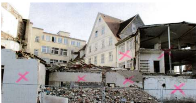
Abb. 24: Gebäudekomplex vor dem weiteren Abriss im Februar 2018. Markierte Gebäude wurden abgerissen.
