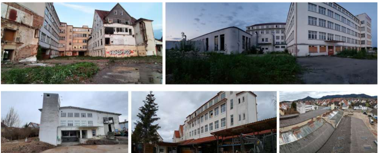
Abb. 11: Außenfassaden der Gebäude mit erhöhtem Quartierpotenzial und Blick auf einen Teil des Dachs.
