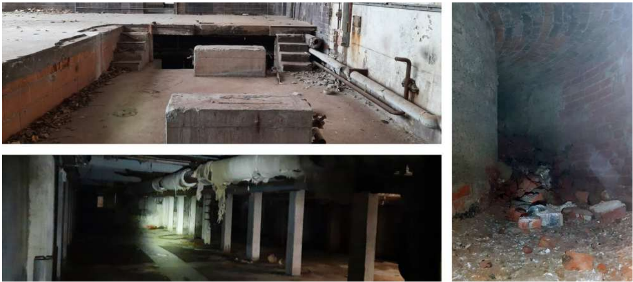
Abb. 15: Oben links: Einflugmöglichkeit in den Keller über das Kesselhaus 2. Unten links: einer der Kellerbereiche. Rechts: Blick in den teilweise abgerissenen und jetzt verschütteten Heizkessel bei Gebäude 2.
