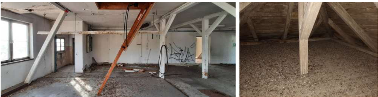
Abb. 13: Ehemals von Tauben bewohnter Dachstuhl des Gebäudes 4 (mittig) ohne Hinweise einer Nutzung durch Fledermäuse.
