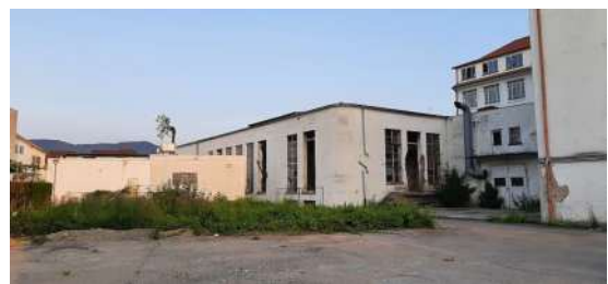
Abb. 16: Drei Einflüge der Zwergfledermaus ins Kesselhaus während der Ausflugskontrolle am 21.07.21.
