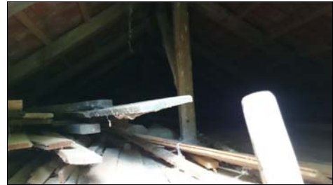
Abbildung 18: Dachboden der kleinen Hütte im 'Raubrühl'
