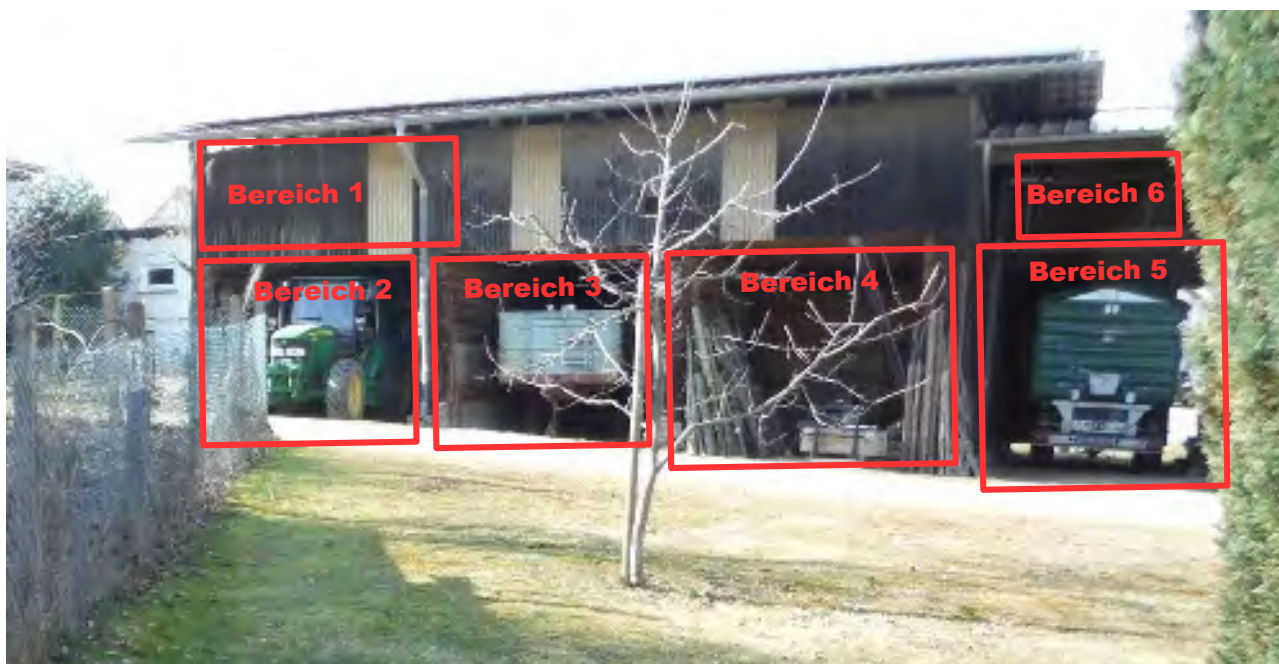
Abb. 6: Foto des landwirtschaftlichen Betriebs und Einteilung der maßgeblich emittierenden Bereiche der Scheune
