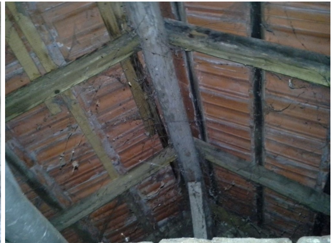
Abb. 13: Blick in den Dachstuhl des Schuppens
