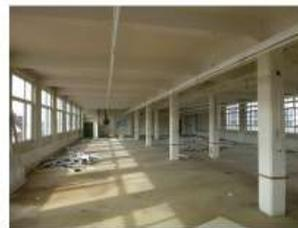
Asbest- und MKW-haltiger Holzzementestrich (in allen Stockwerken von Gebäude 4 Ost)
