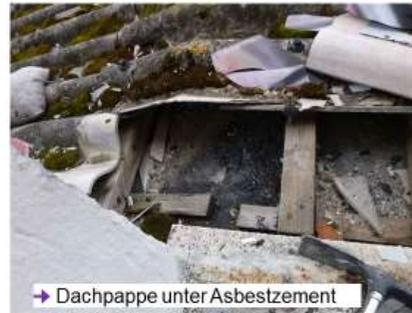
→ Dachpappe unter Asbestzement
