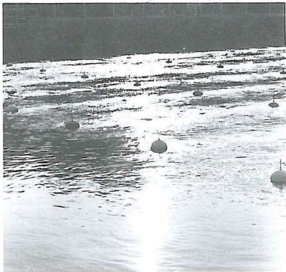
Schwimmkugeln tragen die Belüftungsrohre
