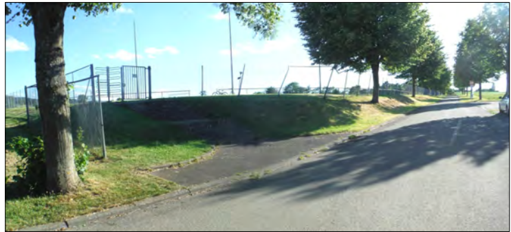
Abb. 7: Zugang zum Sportgelände mit einer Treppenanlage am Rand der ausgewiesenen „Fläche für den Gemeinbedarf“
